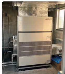
音楽室系統空調機更新
