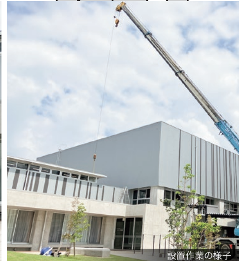
設置作業の様子
