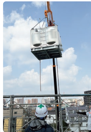
クレーン車による 高架水槽の入替作業
